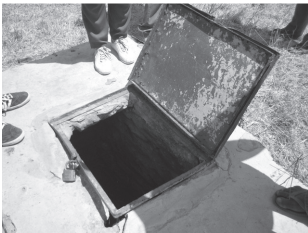
Ryc. 14. Studnia jest chroniona pokrywą z blachy, fot. M. Szupejko
